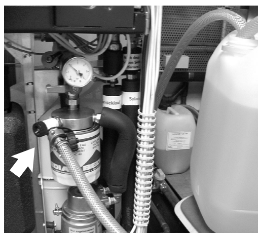
Tubo flessibile di riempimento sulla valvola di riempimento
