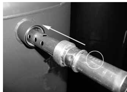
Inserimento della lancia con il segno «in alto» rivolto in alto
