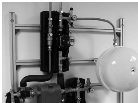
Montare il vaso di espansione
