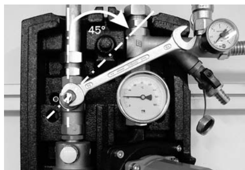
Valvola di non ritorno alla mandata solare con valvola di arresto (AV) sbloccata
