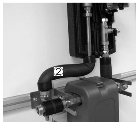
Tubo di collegamento inserito
