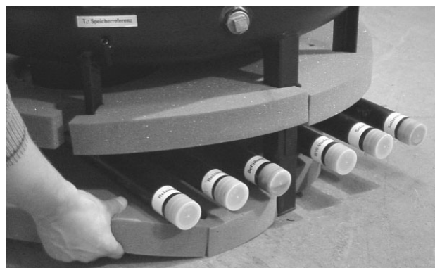
Fig. 5: Base d'isolamento (qui: accumulatore con tubazioni senza allacciamento)
