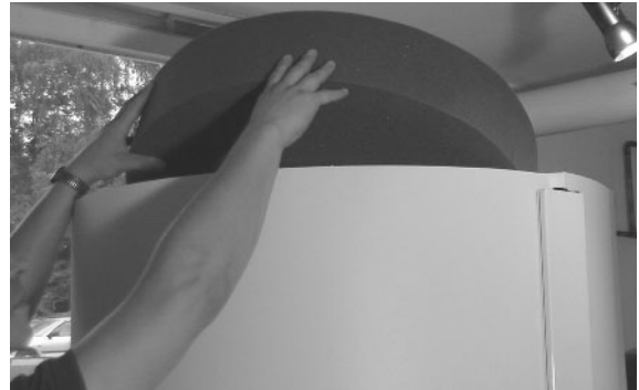
Fig. 11: Calotta circolare di copertura
