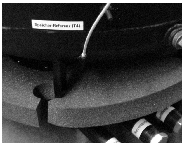
Fig. 7: Montaggio della sonda inferiore T4 (esempio)
