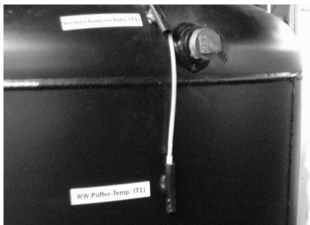
Fig. 8: Montaggio della sonda superiore T1 (esempio)
