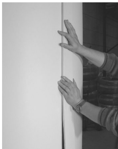
Fig. 10: Montaggio del listello di copertura
