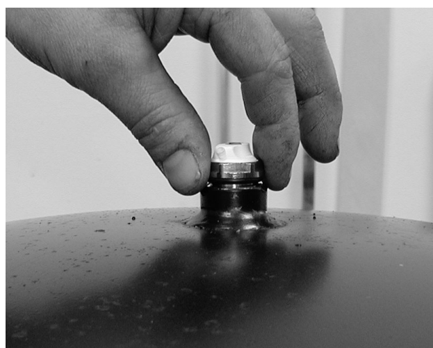
Fig. 6: Avvitare il dispositivo manuale di scarico condensa
