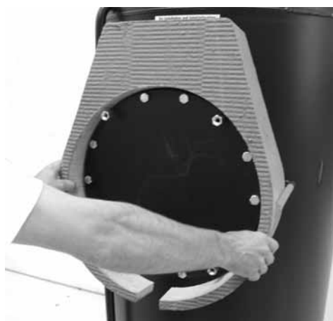
Applicare l'isolamento posteriore della flangia
