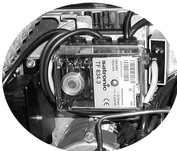
Vista in dettaglio del dispositivo di accensione automatico SÖ NT con pulsante di reset
