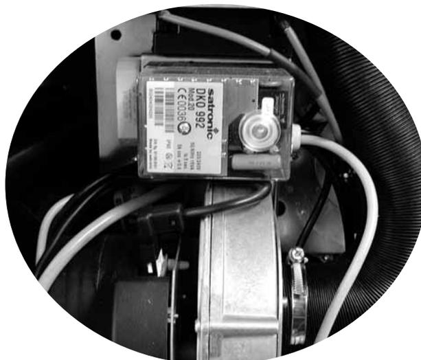
Vista in dettaglio del dispositivo di accensione automatico SÖ BW con pulsante di reset
