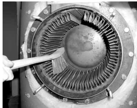
Pulizia dello scambiatore di calore
