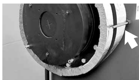
Isolamento posteriore della flangia completamente montato
