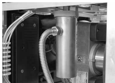
Sifone con tubo flessibile della condensa
