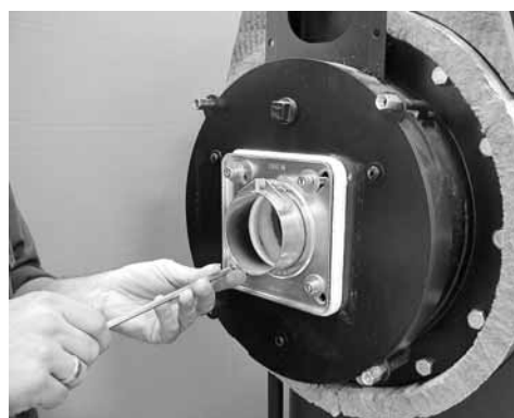
Flangia del bruciatore con guarnizione
