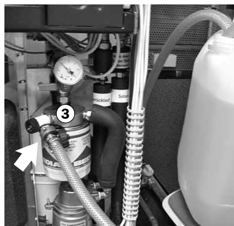
Tubo flessibile di riempimento sulla valvola di riempimento
