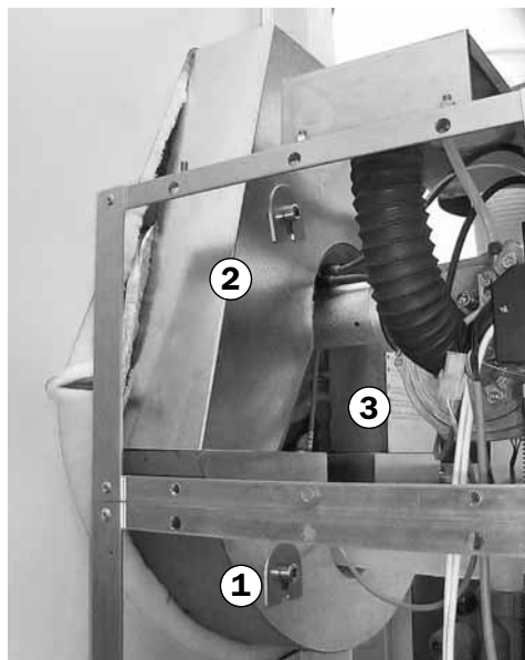
Isolamento anteriore della flangia montato
