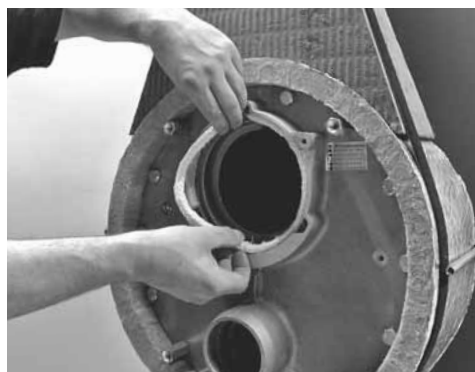
Inserimento della corda di tenuta del bruciatore
