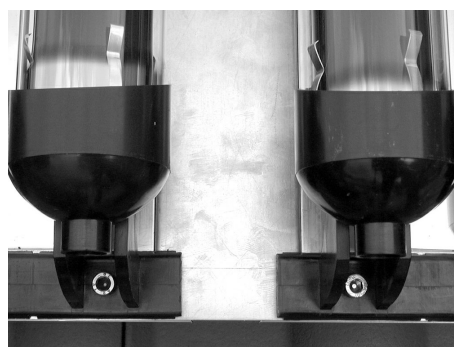
Lamiera di congiunzione posata a filo in basso, tubi avvitati
