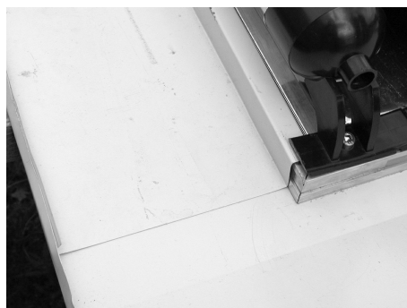
Lamiera laterale inserita, tubi nuovamente avvitati
