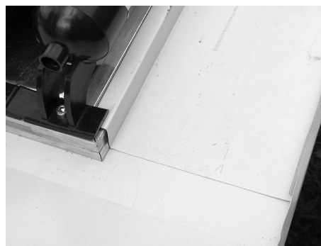
Lamiera laterale inserita, tubi nuovamente avvitati
