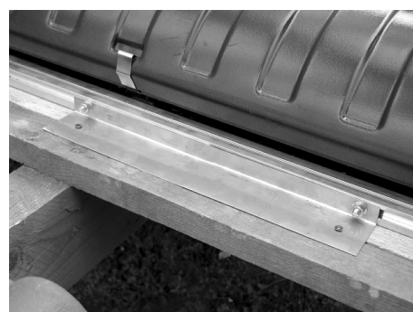
Una lamiera di supporto per ogni collettore
