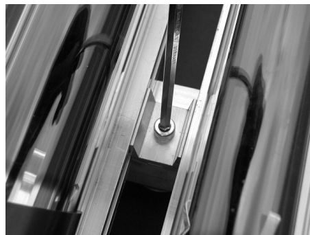
Per concludere, serrare con forza i blocchi centrali
