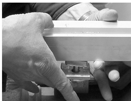
Inserire la vite con testa a martello nella traversa
