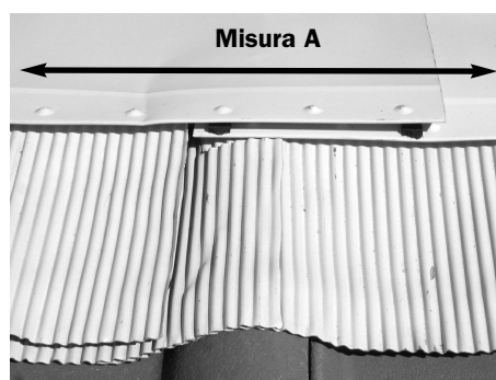
I grembiuli si sovrappongono secondo la misura A
