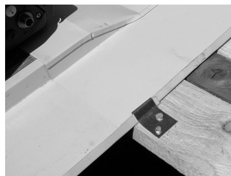
Fissare a destra e sinistra le lamiere laterali e superiori ai lati dei collettori
