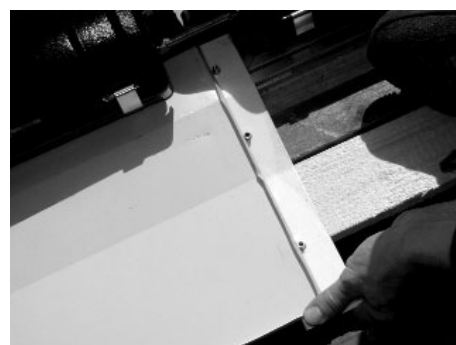
Inserire la parte inferiore della congiunzione per lamiere superiori sotto le lamiere
