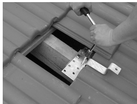
Fissare il supporto sul tetto
