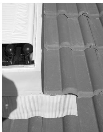
Copertura sul lato
