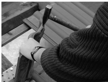
Rimuovere le nervature trasversali dalla tegola
