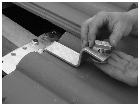
Inserire la vite con testa a martello
