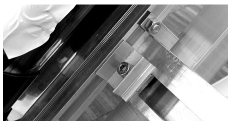
Avvitare debolmente dispositivo di bloccaggio ai bordi a sinistra
