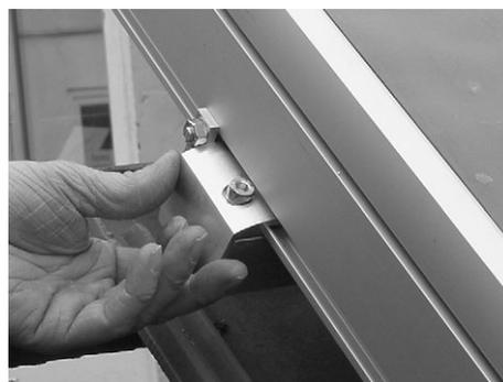
**Corretto posizionamento di un dispositivo di blocco a sinistra**
