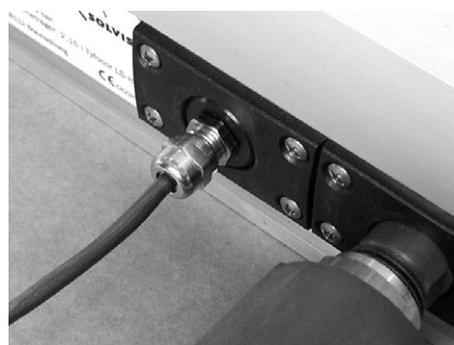
Sensore inserita fino a fine corsa ed avvitata
