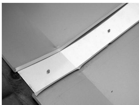
Parte inferiore della congiunzione tra lamiere posizionata, con sovrapposta la lamiera superiore successiva
