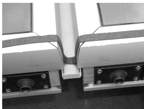
Nastro impermeabilizzante anche intorno alla lamiera di congiunzione
