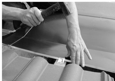
**Fissare la lamiera superiore sulla parte superiore del collettore**
