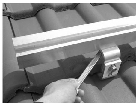
**Stringere saldamente la traversa nel dispositivo di fissaggio sul tetto**
