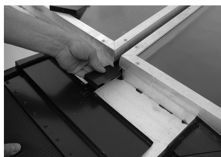
Fig. 147: Inserire la connessione centrale per i grembiuli
