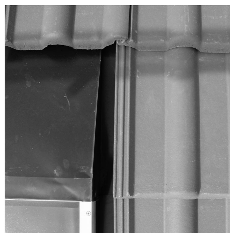
Fig. 34: Ricoprire i lati del collettore con le tegole
