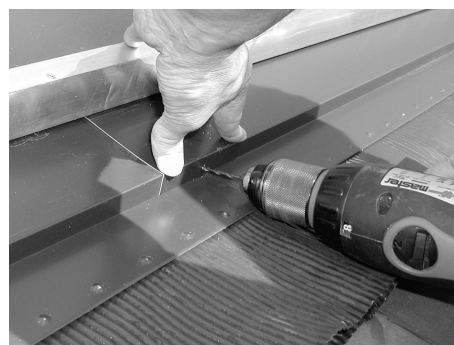
Fig. 18: Premere, forare ed avvitare i fissaggi
