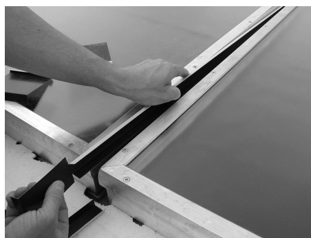
Fig. 48: Posizionare la guida centrale verticale
