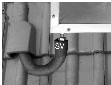
Fig. 217: Collegamento (mandata solare) con isolamento
