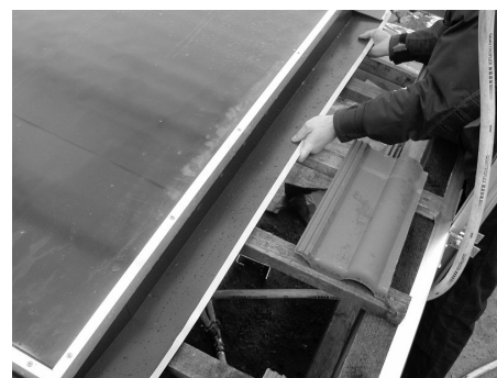
Fig. 97: Inserire le lamiera laterali e posizionarle sull'angolo del grembiule
