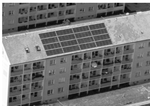
Fig. 123: Montaggio integrato nel tetto di campi di collettori
