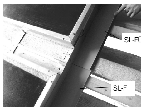
Fig. 99: Montare la lamiera laterale superiore SL-FÜ
