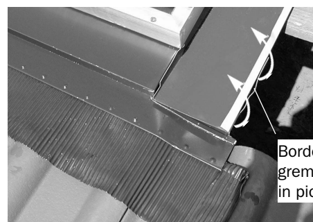
Fig. 98: Piegare il bordo del grembiule su quello della lamiera laterale
