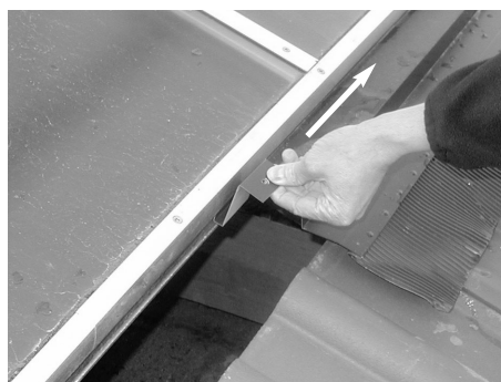
Fig. 13: Inserire due fissaggi per grebiule
