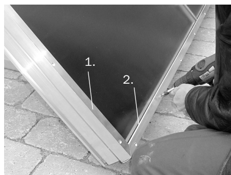
Fig. 193: Montare il profilato a clip ai bordi
