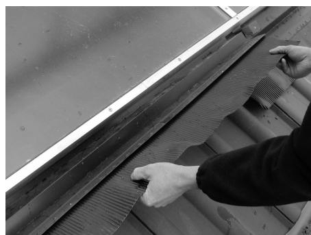
Fig. 145: Inserire gli ulteriori grembiuli
