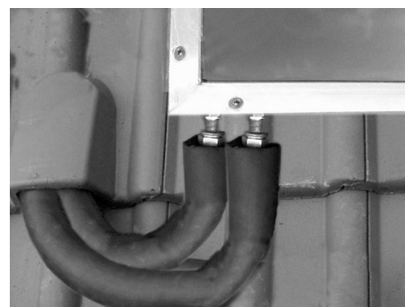
Fig. 198: Collegamento con isolante
