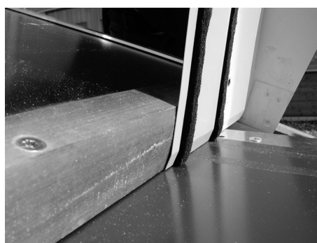
Fig. 106: Inserire la parte superiore dell'angolo lamiera intermedia
