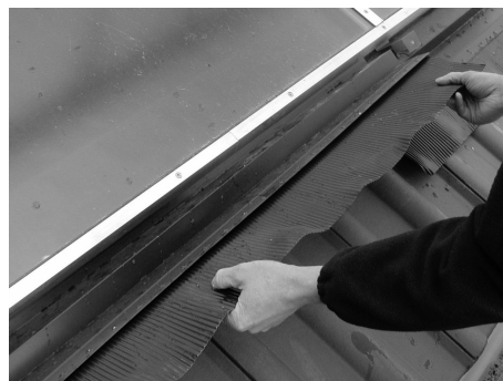
Fig. 47: Inserire gli ulteriori grembiuli
