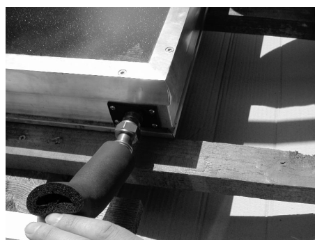
Fig. 210: Inserire e serrare il collegamento inferiore
