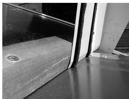
Fig. 167: Inserire la parte superiore dell'angolo lamiera intermedia
