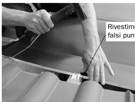
Fig. 118: Fissare la lamiera superiore sul lato superiore del collettore
