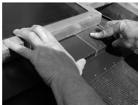
Fig. 46: Premere ed allineare fissaggi ed angoli
