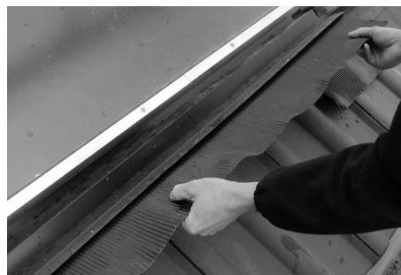
Fig. 152: Inserire ulteriori grembiuli
