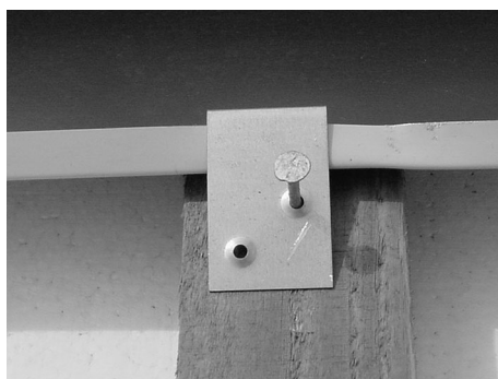
Fig. 185: Fissare le lamiere laterali e superiori ai lati destro e sinistro del collettore
