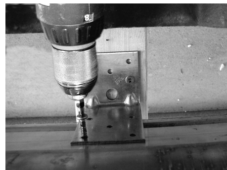
Fig. 87: Fissaggio superiore del collettore
