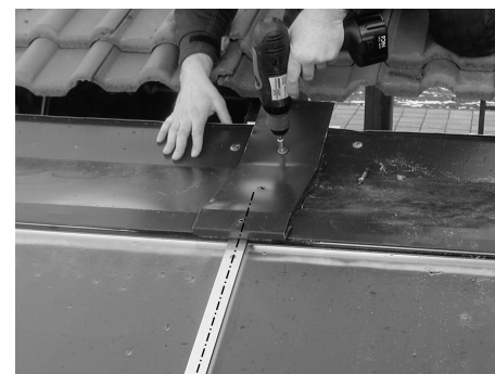
Fig. 184: Posizionare, allineare ed avvitare la congiunzione tra lamiere superiori
