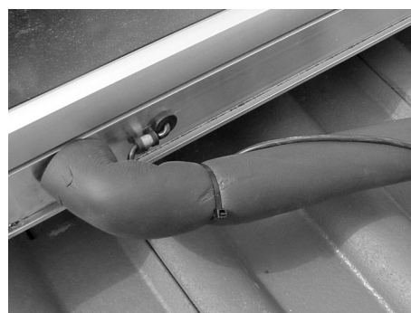
Fig. 226: Posare il cavo della sonda
