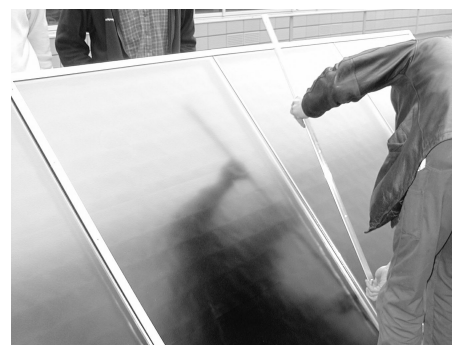
Fig. 196: Come ultima cosa, montare il listello trasversale di copertura
