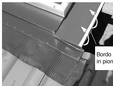
Fig. 60: Piegarlo il bordo del grembiule su quello della lamiera laterale
