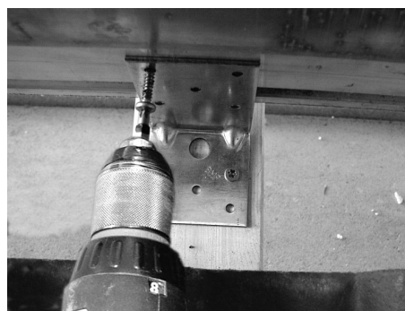
Fig. 10: Allineare il collettore, montare le staffe superiori ed avvitare tutte le staffe al collettore
