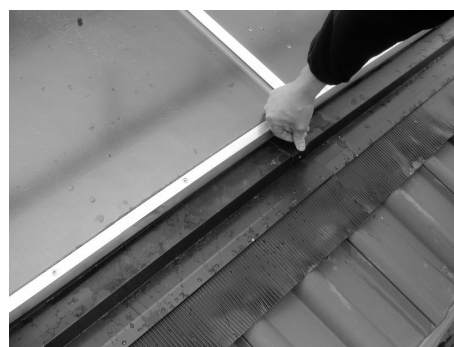
Fig. 17: Allineare grembiuli e fissaggi
