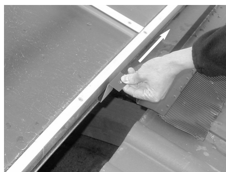
Fig. 45: Inserire due fissaggi per grembiule
