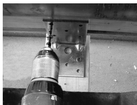
Fig. 40: Allineare il collettore, montare le staffe superiori ed avvitare tutte le staffe al collettore
