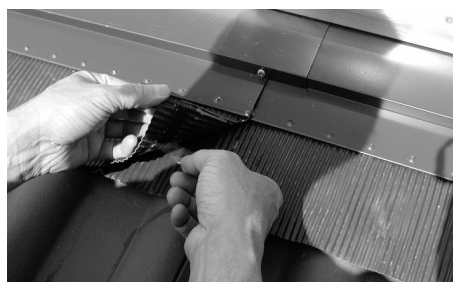
Fig. 156: Togliere le strisce protettive e premere con forza i grembiuli
