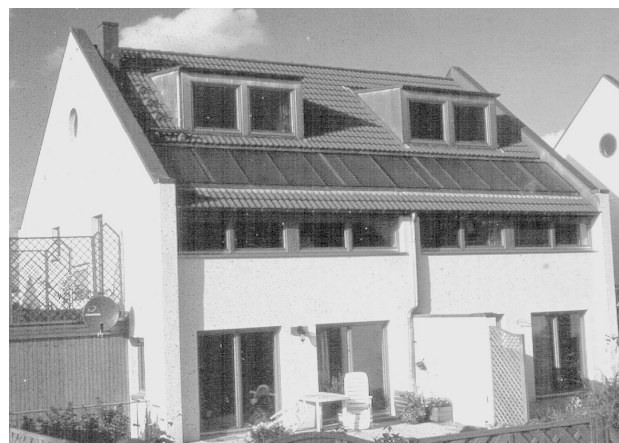
Fig. 35: Montaggio affiancato integrato nel tetto
