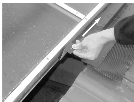
Fig. 143: Inserire due fissaggi per grembiule
