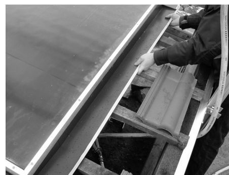
Fig. 20: Inserire le lamiere laterali e posizionarle sopra gli angoli dei grembiuli
