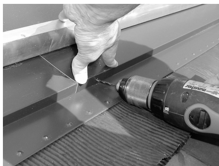
Fig. 57: Premere, forare ed avvitare i fissaggi per grembiuli
