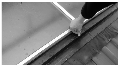
Fig. 56: Allineare grembiuli e fissaggi.
