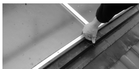
Fig. 154: Allineare grembiuli e fissaggi
