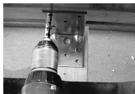
Fig. 129: Avvitare la staffa inferiore con il collettore
