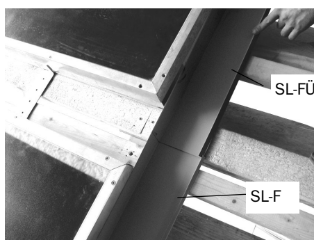
Fig. 159: Montare la lamiera laterale superiore SL-FÜ
