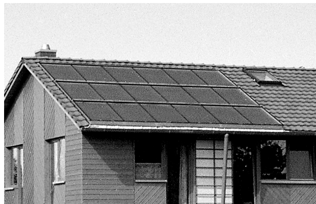
Fig. 75: Montaggio sovrapposto integrato nel tetto
