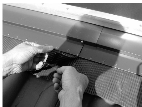
Fig. 58: Togliere le strisce protettive e premere con forza i grembiuli
