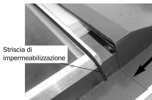
Fig. 178: Inserire l'angolo della lamiera superiore destra
