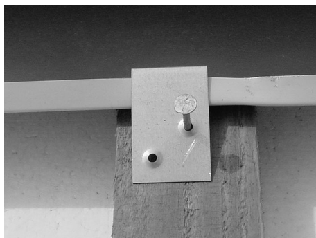
Fig. 117: Fissare le lamiere laterali e superiori ai lati destro e sinistro del collettore
