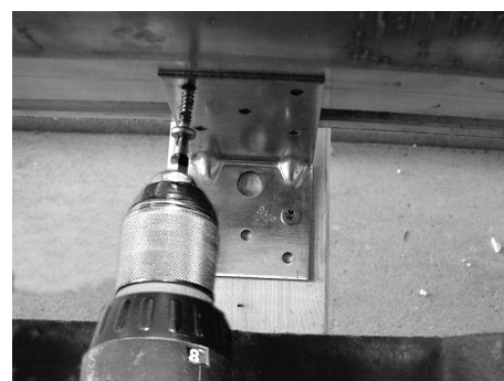
Fig. 82: Avvitare la staffa inferiore con il collettore
