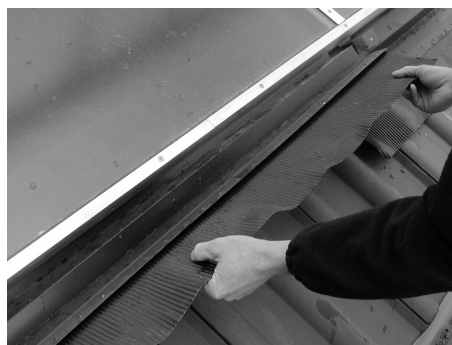
Fig. 54: Inserire ulteriori grembiuli
