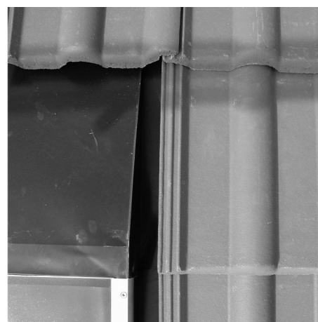
Fig. 122: Ricoprire i lati del collettore con le tegole
