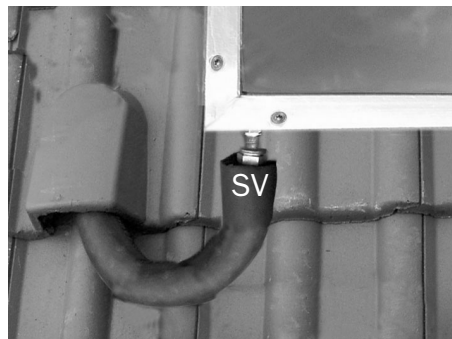
Fig. 221: Collegamento (mandata solare) con isolamento
