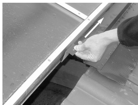
Fig. 90: Inserire il grembiule a destra con l'angolo
