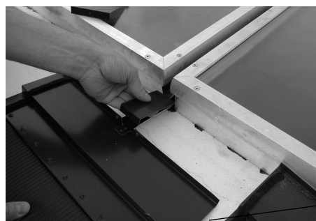
Fig. 49: Inserire la connessione centrale per i grembiuli
