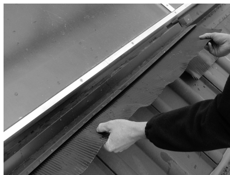
Fig. 92: Inserire gli ulteriori grembiuli
