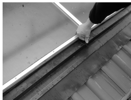
Fig. 94: Allineare grembiuli e fissaggi
