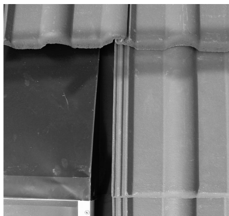
Fig. 190: Ricoprire i lati del collettore con le tegole
