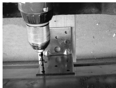
Fig. 138: Fissaggio superiore del collettore
