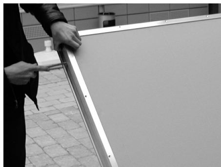
Fig. 35: Rimozione dei profilati a clip e dei cartoni di protezione
