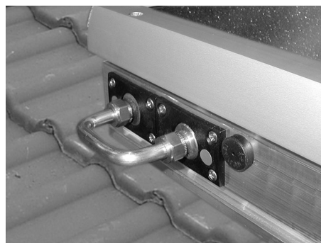
Fig. 47: Curva di raccordo montata
