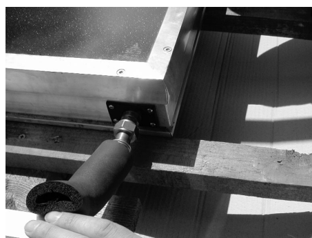
Fig. 57: Inserimento del collegamento inferiore e fissaggio
