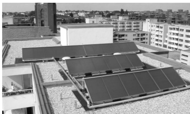
Fig. 21: Installazione su tetto piano, impianto solare a Wedding nel quartiere Brunnen (fonte: DEGEWO)
