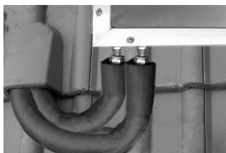
Fig. 42: Collegamento con isolamento
