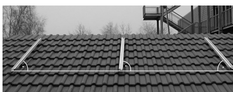
Fig. 17: Installazione completa dei telai di sostegno (F-552 o F-652)
