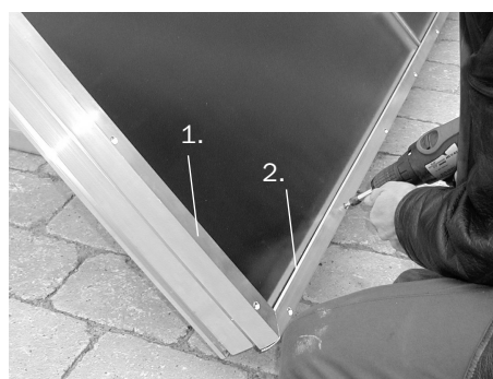
Fig. 37: Installazione dei profilati a clip dai bordi
