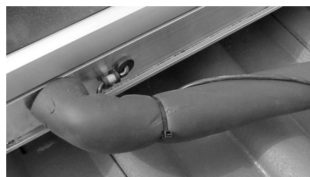
Fig. 73: Posa del cavo della sonda
