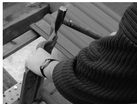
Fig. 11: Eliminazione delle alette della tegola
