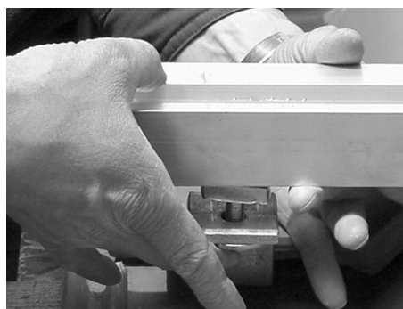
Fig. 14: Inserimento della vite con testa a martello nel telaio di sostegno.
