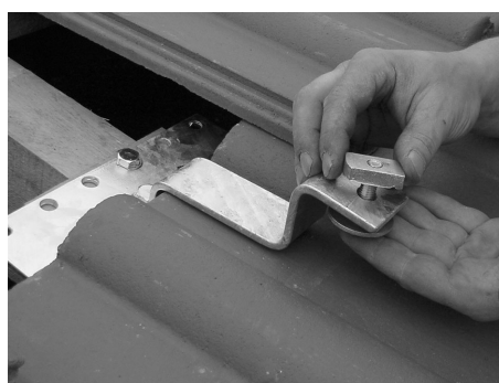
Fig. 13: Inserimento della vite con testa a martello a martello
