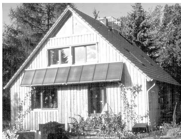
Fig. 22: Installazione a parete
