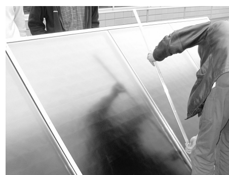
Fig. 40: Infine montare i listelli di copertura trasversali
