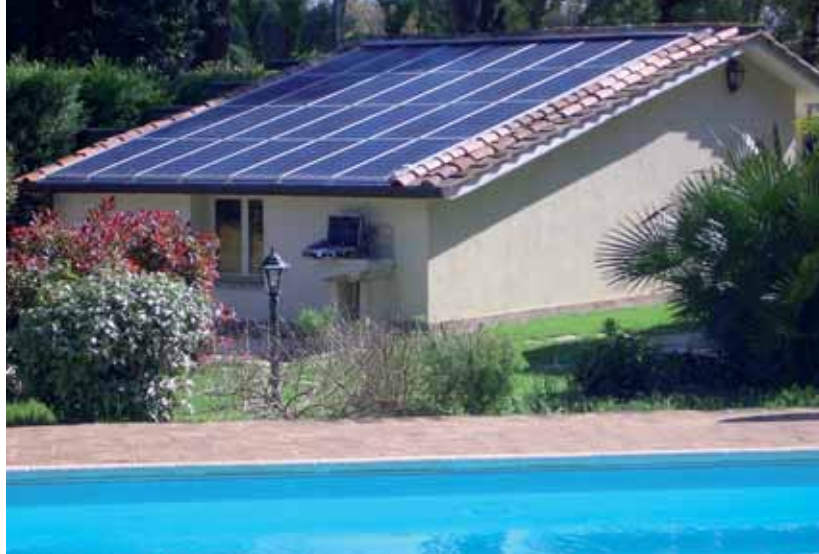
Esempio di impianto fotovoltaico integrato - Foto Schüco
