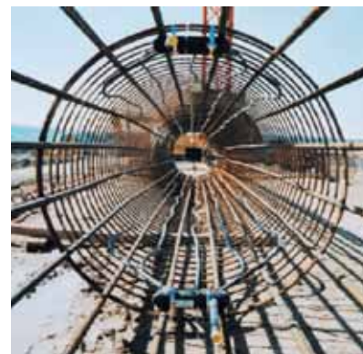
Dettaglio dell'armatura di un palo energetico sul cantiere del futuro Dock Midfield, aeroporto di Zurigo (foto FDV)
