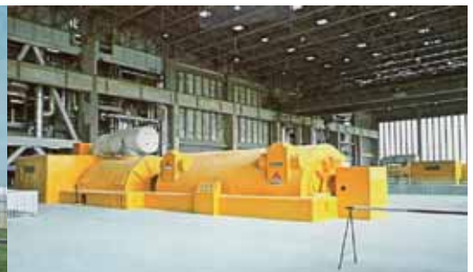
Veduta panoramica di una centrale termoelettrica 2x200 MW e sala macchine
