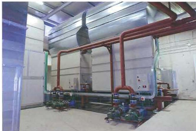
Le due torri evaporative sono dotate di ventilatori centrifughi, da circa 500 kW ciascuna, silenziate sulla presa dell'aria posta in corrispondenza di un cavedio appositamente realizzato per evitare la diffusione dei rumori all'intorno.
