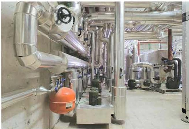
A fianco dei chiller sono situate le elettropompe primarie dell'acqua calda e refrigerata, i serbatoi inerziali e le pompe dell'acqua di condensazione, oltre alle elettropompe secondarie per le centrali di trattamento dell'aria.
