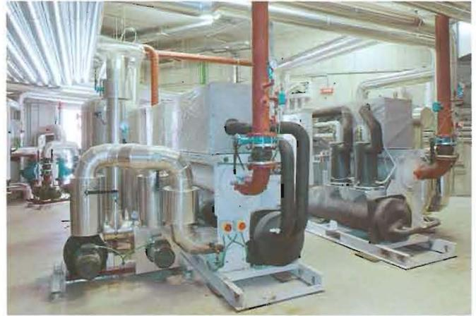
I due gruppi frigoriferi sono a condensazione ad acqua, multicompressore a vite, ognuno con una potenza di circa 400 kW ciascuno; il funzionamento è a gas refrigerante ecologico R 134a.
