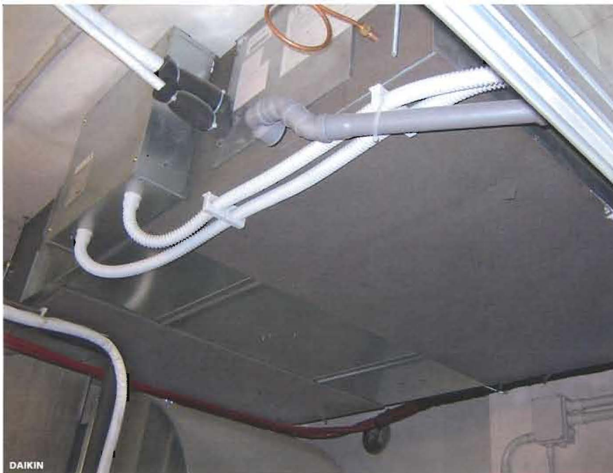
2 Esempio di unità interna VRV canalizzabile.
