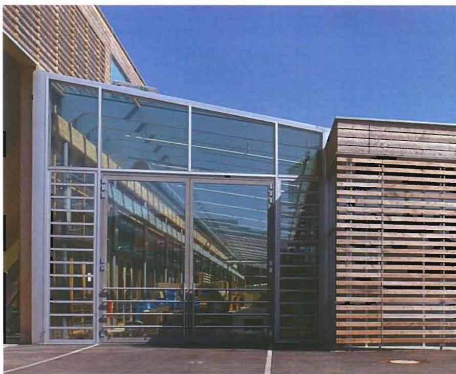
7 Il passaggio di collegamento coperto da un tetto vetrato permette di sfruttare gli apporti di calore per preriscaldare l'aria di ventilazione.
