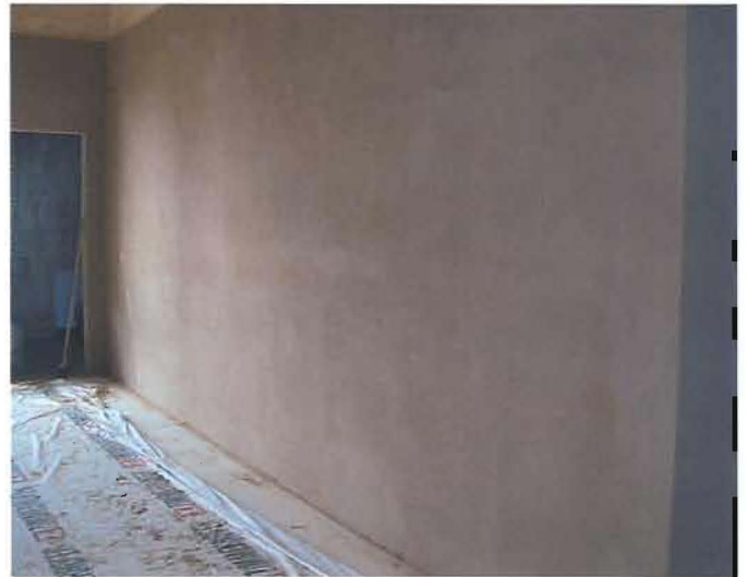
5 Per la finitura delle pareti interne è stato scelto l'intonaco d'argilla, un materiale colorato naturale e traspirabile.
