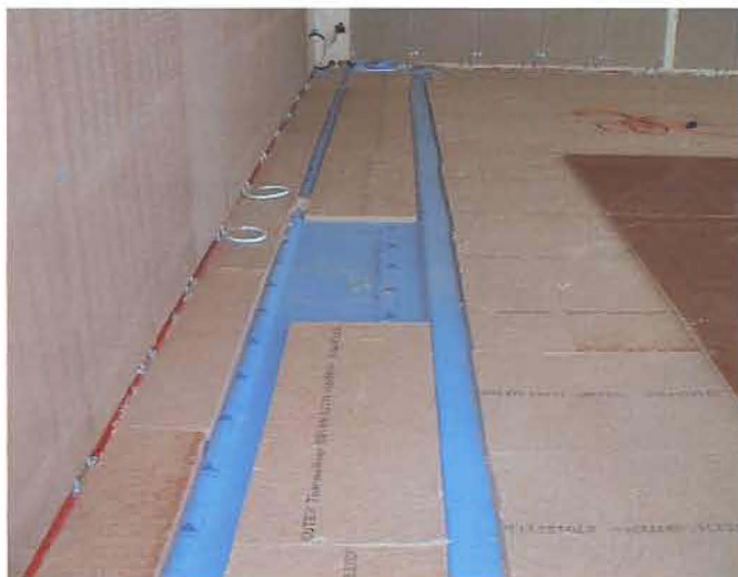
6 Per l'isolamento a pavimento è stata usata una coppia di pannelli in fibra di legno.
