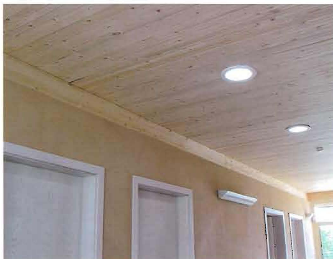
7 Per l'illuminazione dei lunghi disimpegni che portano all'atrio centrale è stato adottato il sistema di illuminazione diurna "solar tube".
