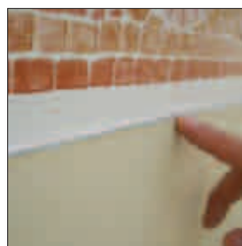
Sigillatura con PVC liquido alta densità
